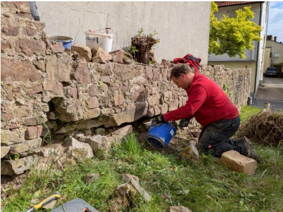
Im Mai 2026 wurde im Rahmen der Sanierungsarbeiten rund um den Gemeinderaum auch die denkmalgeschützte Kirchenmauer an einigen Stellen fachmännisch saniert. Foto: M. Boeckh
